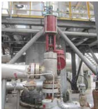
金澳科技(湖北)化工有限公司110万吨/年柴油加氢改质装置上有30台高压调节阀和8台高压切断阀均采用梅索尼兰公司的产品。现场调节阀上的手动装置在梅索尼兰公司的技术员指导下了解到是顶装液压手动千斤顶，严格意义上讲不属于手轮装置，但却能完成手动操作，达到设计要求。
