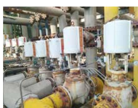
在变压吸附装置中使用的阀门大都是气动截止阀，气动截止阀的正常稳定运行是保证变压吸附装置安全正常运行及产品质量的重要因素。如果气动截止阀因为异常漏气而造成阀门开关较慢、甚至无法开关，以及阀门外漏或内漏，都会影响安全生产或产品气不合格，使得生产线被迫降负荷或停运，无法安全稳定连续运行。所以，生产期间如何根据气动截止阀不同部位的异常漏气现象快速判断出故障原因，及时予以处理，就显得十分重要。本文就变压吸附装置气动截止阀异常漏气原因的快速判定及处理方法进行探讨。
